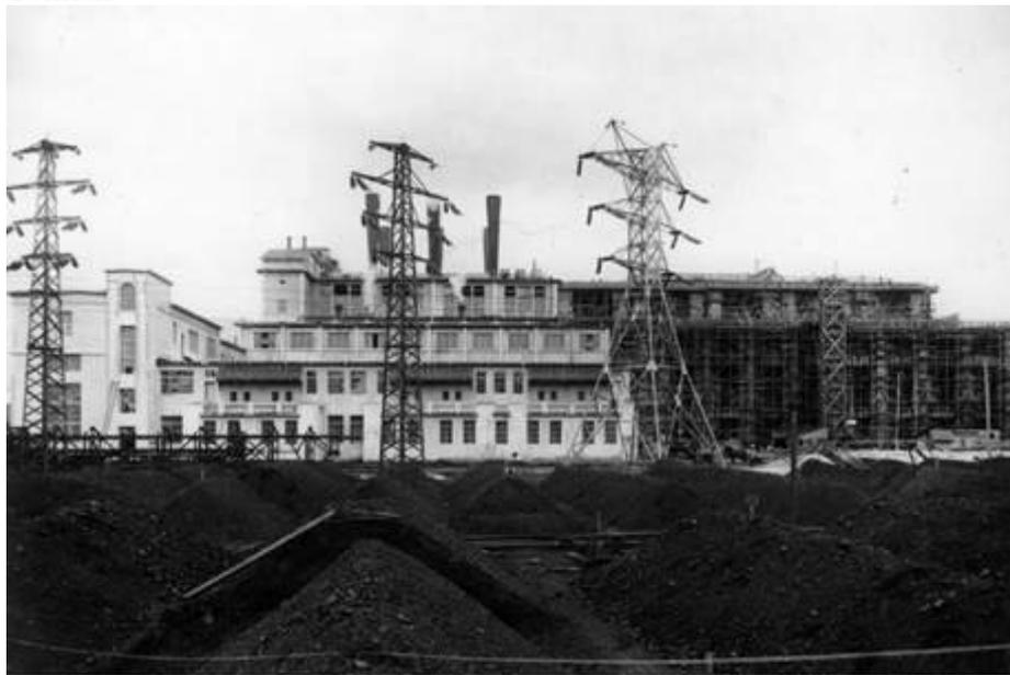
*Вид главного корпуса и опалубки машинного зала 2-й очереди со стороны повысительной подстанции*
